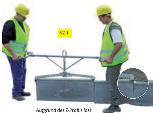
Aufgrund des Z-Profiles löst die Zange beim Aufsetzen ab
