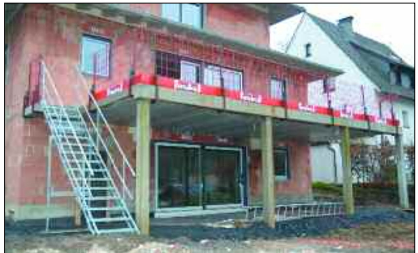
AS- System im Einsatz mit T-Trägerklemmen
