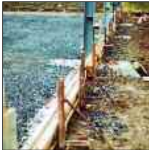
Schalhilfe zur Erstellung von Bodenplatten.
