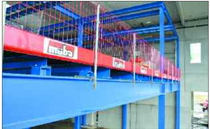
AS- System im Einsatz mit T-Trägerklemmen
