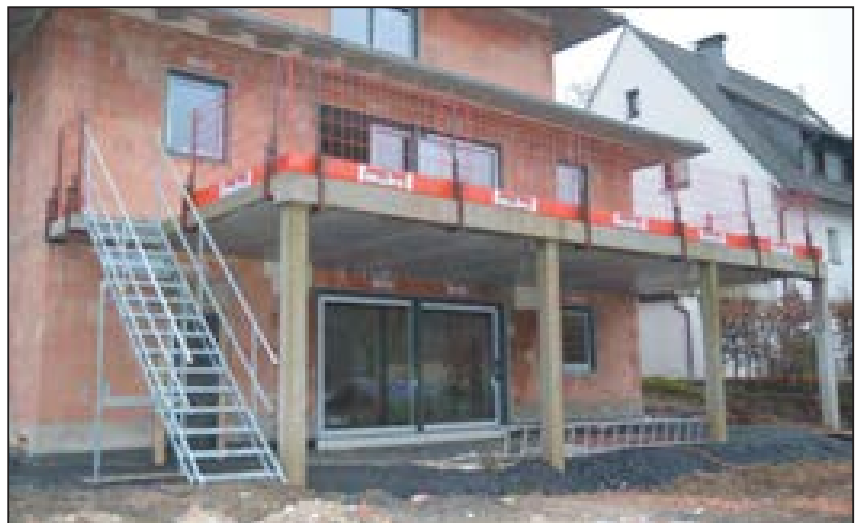
AS- System im Einsatz mit T-Trägerklemmen
