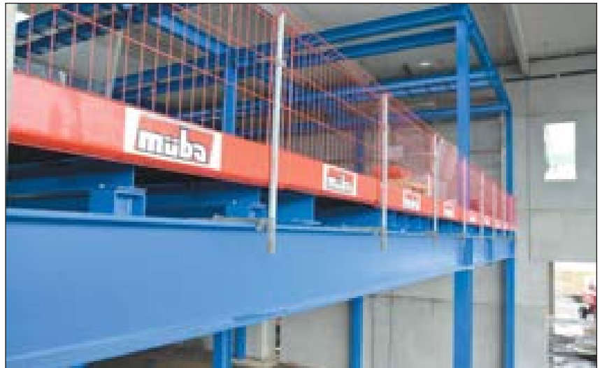
AS- System im Einsatz mit T-Trägerklemmen
